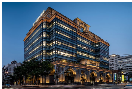
台北 泰安產險大樓
